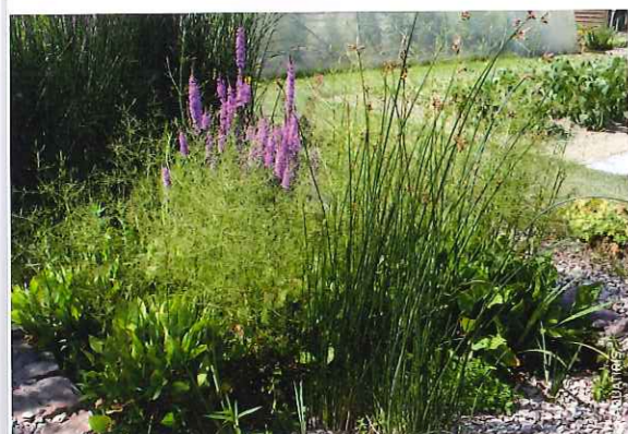
Étape de filtration horizontale
